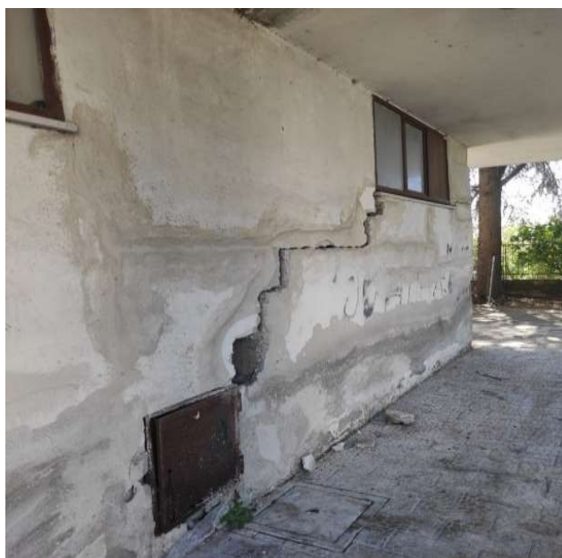
Figura 5 - Tamponatura da demolire e ricostruire
